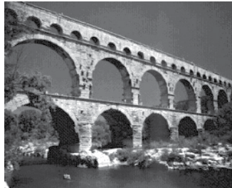
Figura 3 - Ponte du Gard. Fonte: Ponte du Gard (2002)
