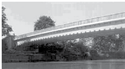
Figura 6 - Ponte de Concreto Protendido de Freyssinet. Fonte: Breve História... (2002).
