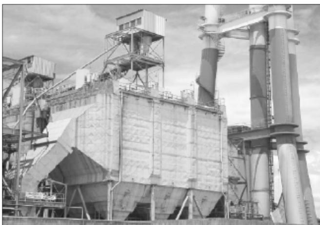
**Figura 1:** Precipitadores Eletrostáticos.
