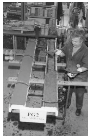
Figura 5 Execução dos reforços com argamassa com adição de sílica ativa.
