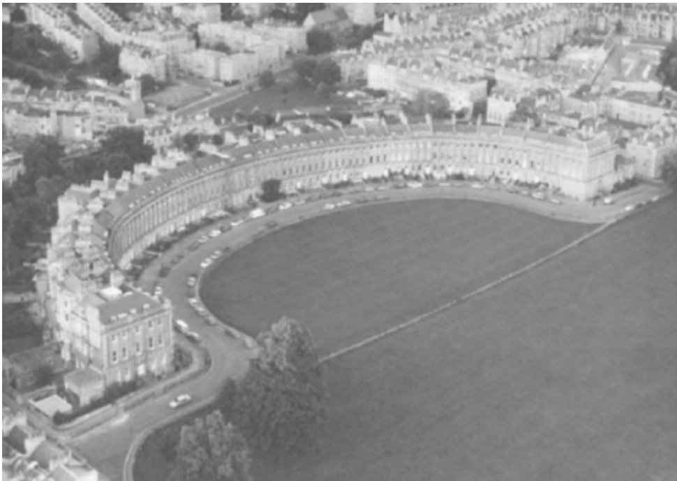
Figura 5 John Wood, The Royal Crescent , 1769. Aspecto formal do edifício articula somente a fachada côncava. Fonte: University of Bath.
