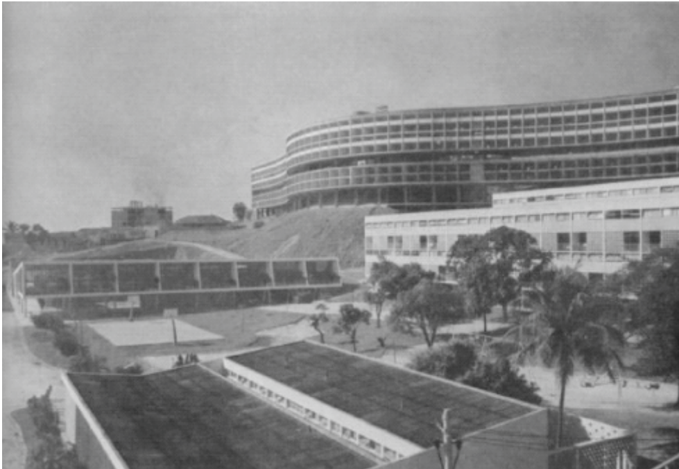
Figura 3 - Affonso Eduardo Reidy, Conjunto Residencial do Pedregulho, 1948. Edificações delimitam e organizam o espaço central do conjunto. Fonte: MINDLIN, 1999, p. 143.
