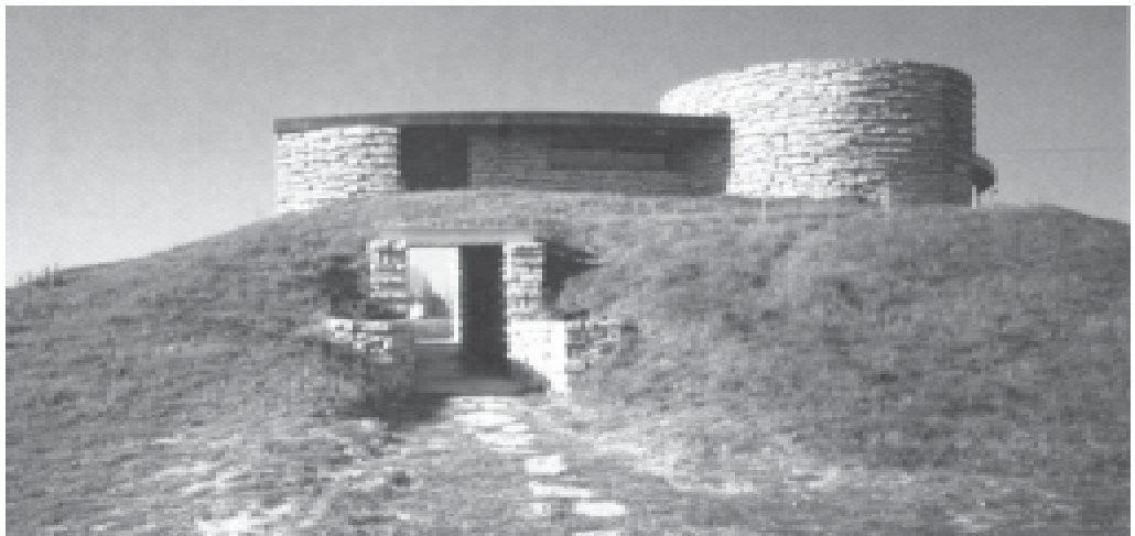
Figura 3 – as características locais como promotoras do processo projetual. O Hemiciclo Solar, casa para Robert Jacobs, Wisconsin – EUA, 1944-48. Vista norte da casa com as paredes protegidas pelo terrapleno por uma questão de isolamento, a fachada sul, oposta, está virada para o movimento do sol. Projeto de F. L. Wright. Fonte: Pfeiffer, 2000.
