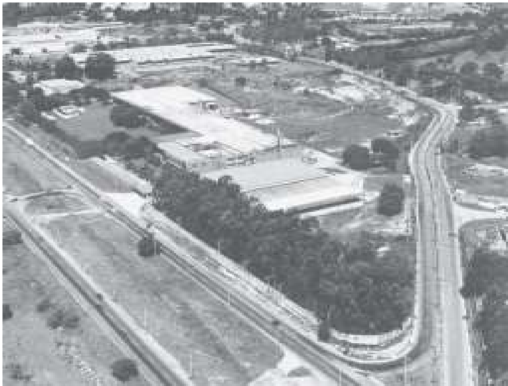
Foto 4 – Vista geral da Recouro, Indústria de Couros Reconstituídos, em Campo Grande, Rio de Janeiro.
