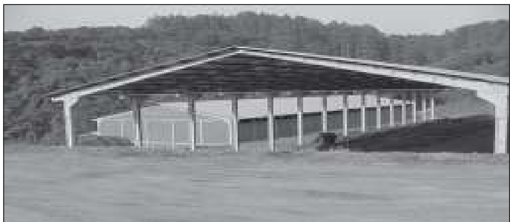
Figura 1 - Vista geral da Central de Resíduos da Roselândia, com destaque para os galpões de armazenamento de resíduos da classe I, ao fundo, e da classe II (em construção), à frente.
