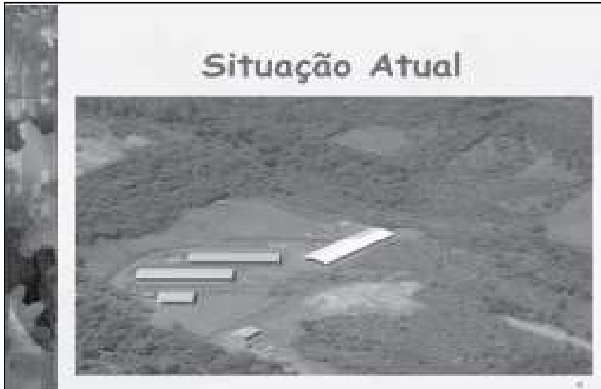
Figura 2 - Vista aérea da central. Fonte: ACI/NH (2003).
