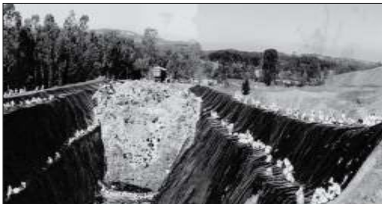
Figura 1 - Vala de disposição dos resíduos (1999). Vista Parcial da área de disposição de resíduos.
