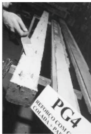
Figura 7 Aplicação da resina epóxi.
