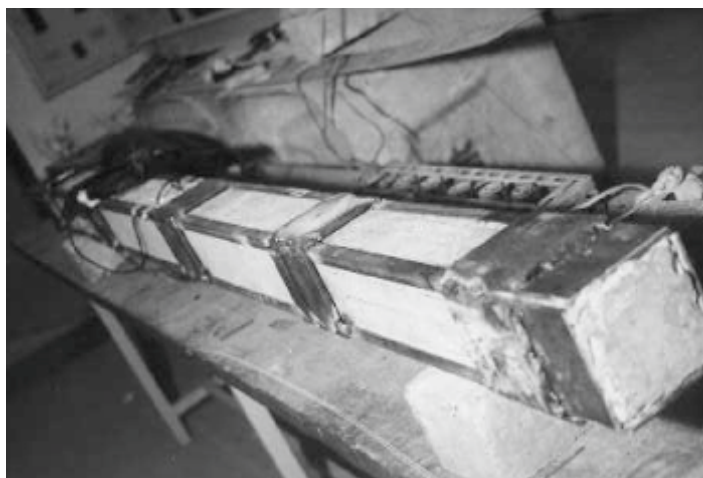
Figura 11 Execução do reforço empregando perfis metálicos.
