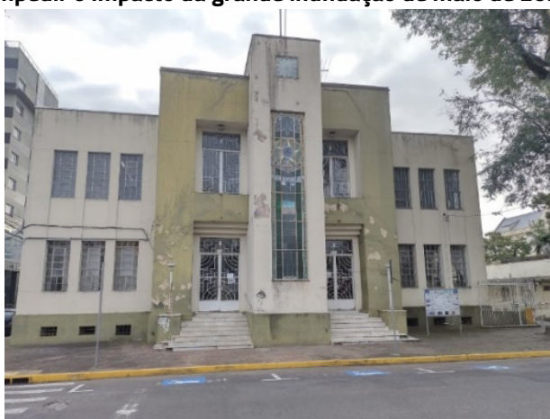
Figura 10 – Pr dio da antiga Prefeitura de S o Leopoldo, constru da em cota elevada, n o suficiente para impedir o impacto da grande inunda o de maio de 2024
