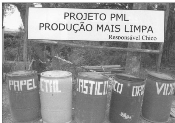
Figura 2: Tonéis de segregação de resíduos implantados em obras da Construtora Melnick para operacionalização do programa de produção mais limpa (PML).
