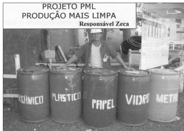
Figura 3: Tonéis de segregação de resíduos implantado em outra obra da Construtora Melnick com o padrinho da obra.
