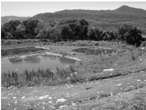
Figura 03: Lagoas de recolhimento e contenção do chorume. Fonte: Pesquisa realizada.
