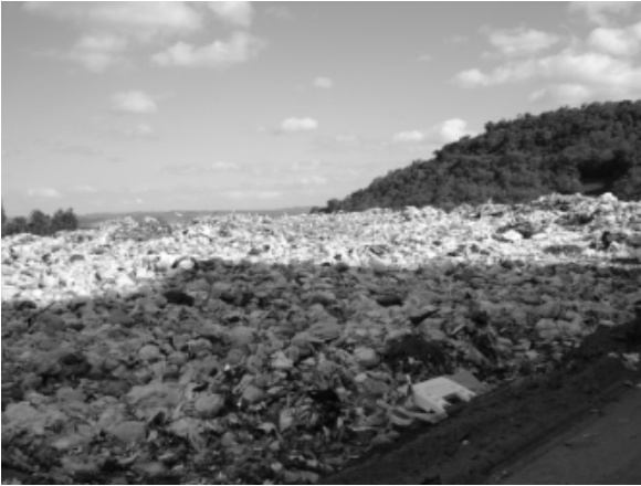
Figura 05: Os resíduos são deixados a céu aberto, não há vestígios de cobertura ou compactação.
