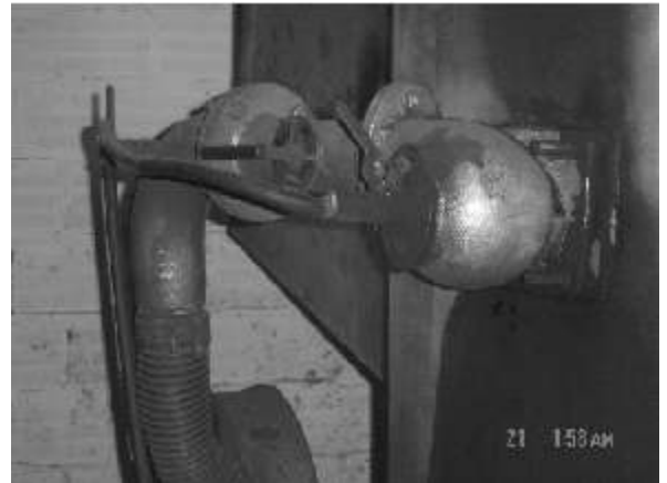
Figura 04: Queimador MAGOPI, 18L/h Óleo Diesel. Fonte: Empresa Siverst Ltda (2005)
