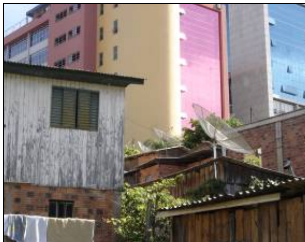
Figura 7 - Contraste da Vila Martin Pilger localizada ao lado da Universidade Feevale Fonte: Acervo do Projeto de Extensão Arquitetura e Comunidade (2010)
