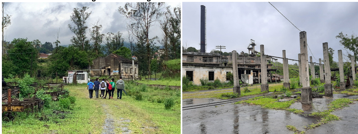
Figuras 4 e 5 - Antiga Fábrica de Cimento Portland de Perus
